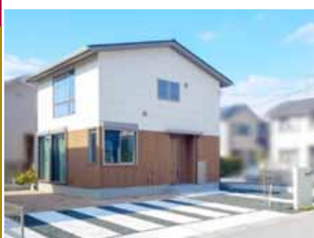
太陽光発電(3.6kW)、オール電化住宅
