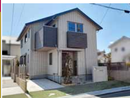
太陽光発電(3.88 kW)、エネファーム
