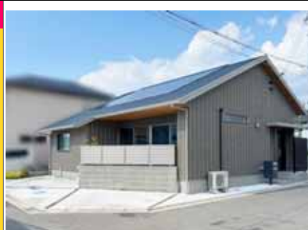
太陽光発電(3.84kW)、オール電化住宅
