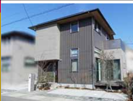
太陽光発電(4.56kW)、オール電化住宅
