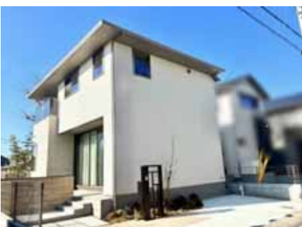
太陽光発電(2.5kW)、エネファーム
